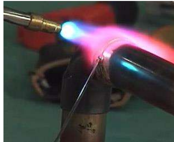
(Şəkil 3) 6. Bərk lehimləmə fotosu
